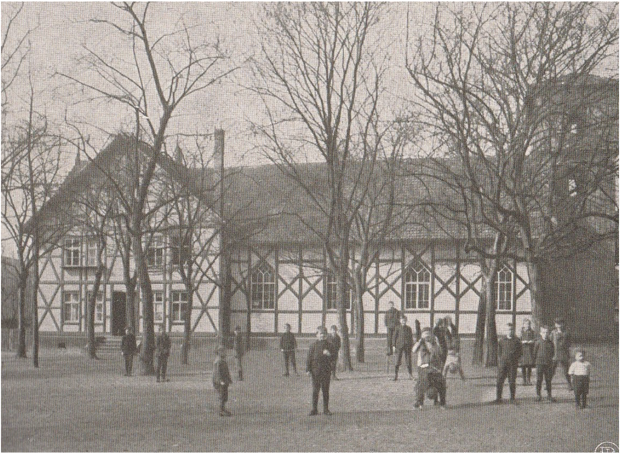
Städtische Turnhalle in der Hainstraße (erbaut 1869/70) Turnstätte des TVH von 1875-1904
