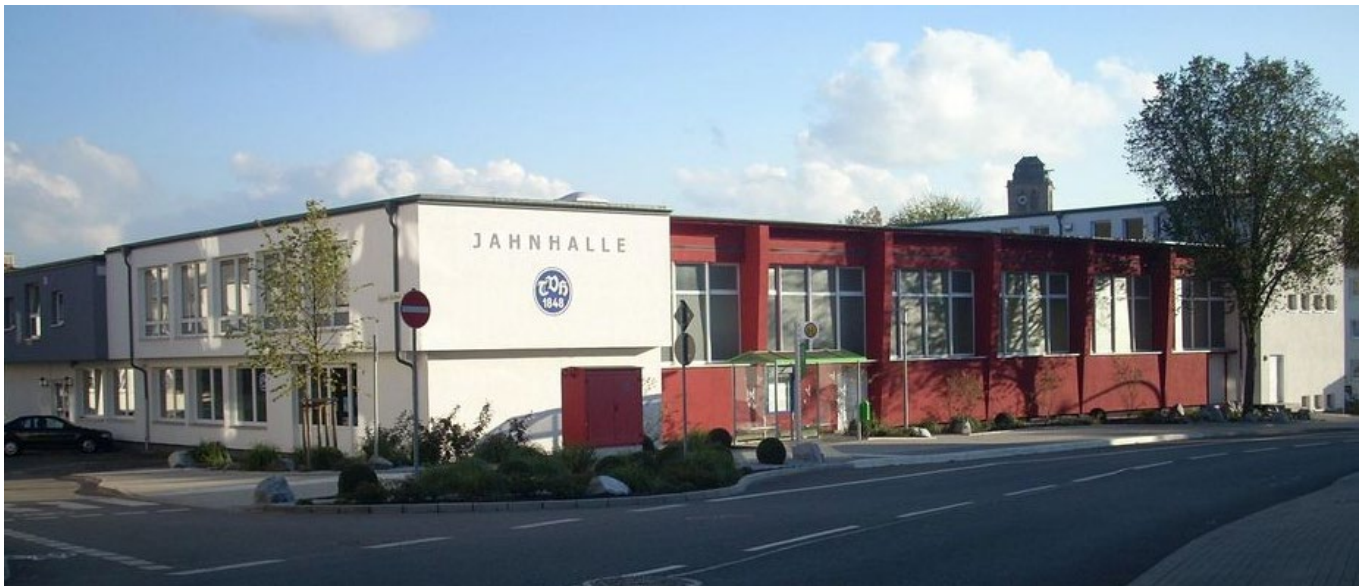
Die Jahnhalle heute (nach grundlegender Sanierung)
