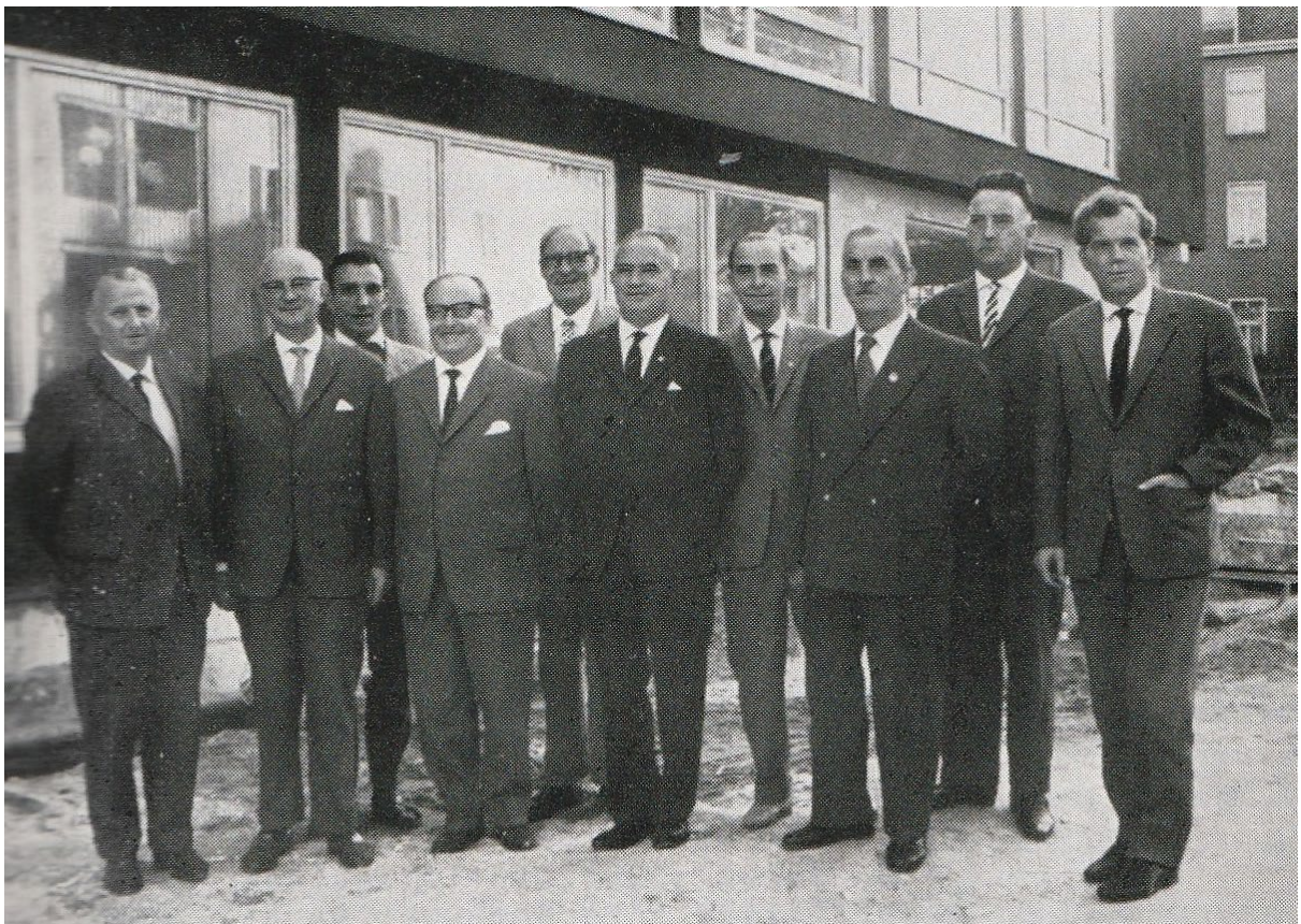
Bau-Ausschuss des TVH zur neuen „Jahnhalle“ (v.l.): Hermann Franke, Willi Hirschhäuser, Manfred Humburg, Georg Fehling, Georg Humburg, Henner Schade, Christian Siebert, Matthias Schönewolf, Fritz Hild, Bauingenieur Rudolf Schloßborn
