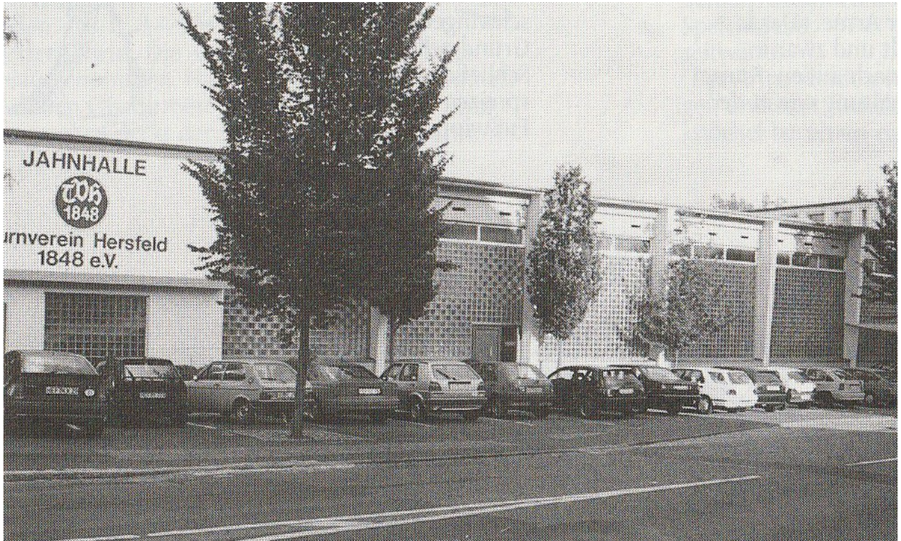
Die Jahnhalle vor der grundlegenden Sanierung
